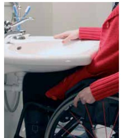
Klemsring mellom heis og servant forhindrer noe i å komme i klem under servant ved bevegelse.
